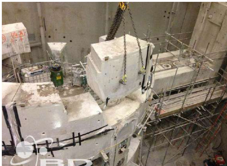
Pembongkaran tangki bertekanan di reaktor terapung, U.S. Army's MH-1A, United States.
